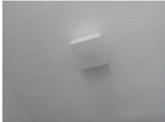
Existujúce žiarovkové osvetľovacie telesá
